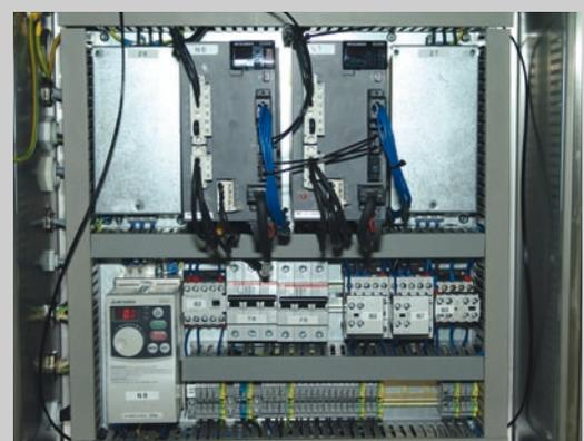
Kompakter geht es nicht: Die zwei Servoverstärker für die Achsen Vorpresse und Fertigpresse wurden unterhalb des Maschinenraums eingebaut.
