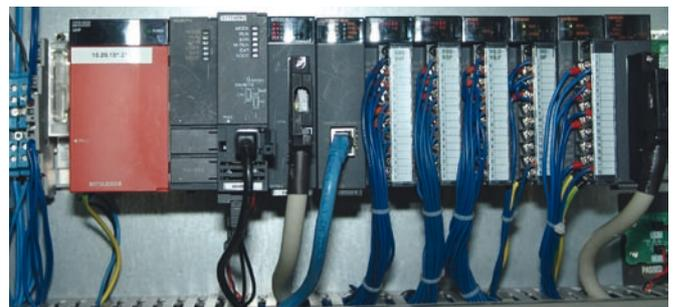
Oben: Die Programmierung der SPS Melsec System Q erfolgte konform zur IEC 61131-3 mit dem IEC-Developer PX IEC von Mitsubishi-Electric.
